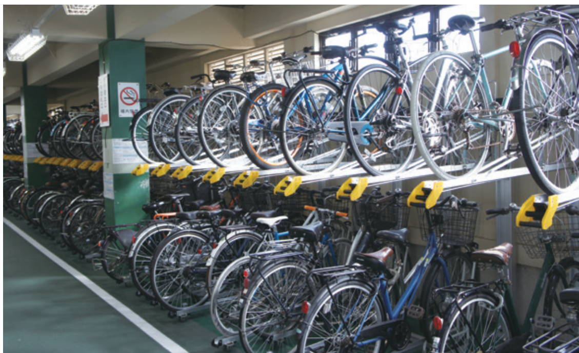
上段ラックが満杯状態のARS(Auto Return Safety)垂直2段式ラック(京都市太秦自転車等駐車場)
