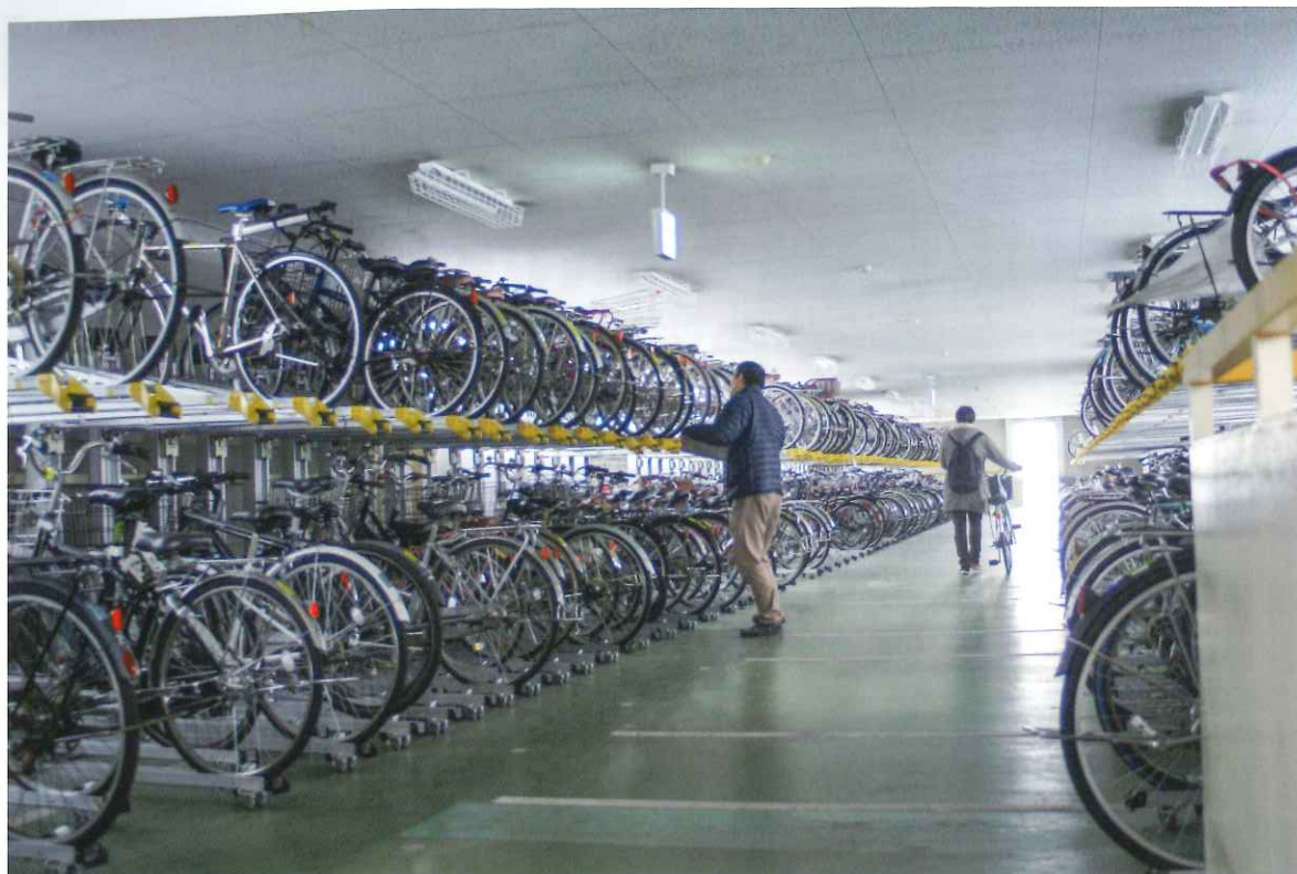
草津駅東自転車駐車場内部。OSSの垂直2段ラックがしっかりと設置されている
