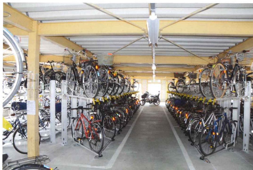
草津駅西口第2自転車駐車場は垂直2段ラックを導入したことで自転車が整然と保管され、全体としてスッキリした印象だ
