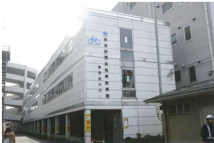
草津駅東自転車駐車場
