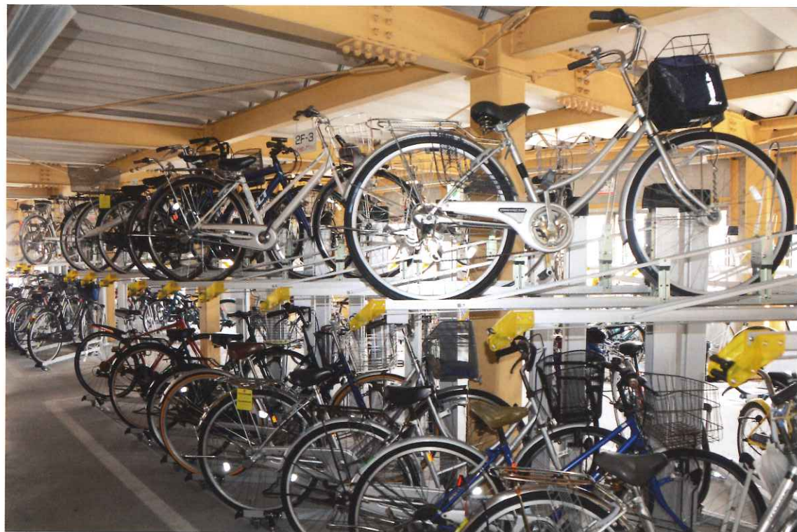
草津駅西口第2自転車駐車場に設置されたOSS製垂直2段ラック
